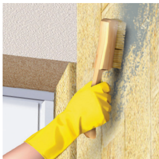
Bước 1: Vệ sinh, xử lý bề mặt bê tông, vữa
