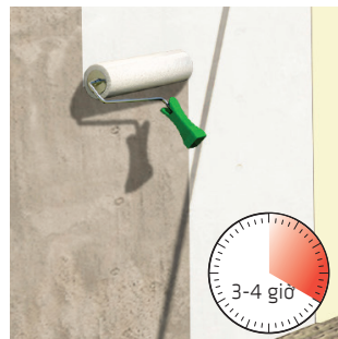
Bước 3: Thi công lớp thứ 1 chờ khô trong khoảng 3-4 tiếng
