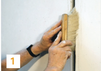
1 Chuẩn bị và làm sạch bề mặt mối nối
